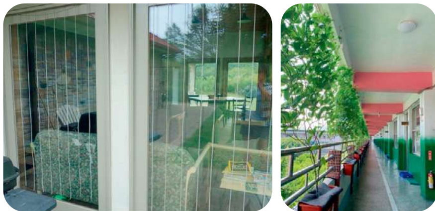
圖、窗邊安裝隱形鐵窗（左）、新北市民安國小窗外懸掛植物（右）
